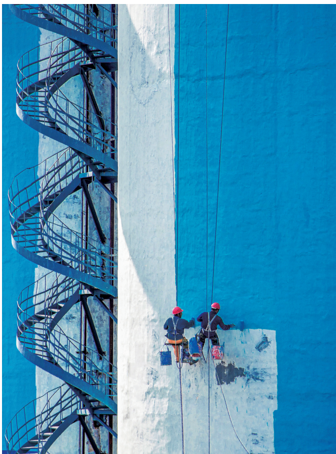
» 工人化身“高空舞者”悬空粉刷巨型筒仓，用双手为冰冷工业建筑赋予色彩。 《煤仓穿上环保蓝》陈忠明
