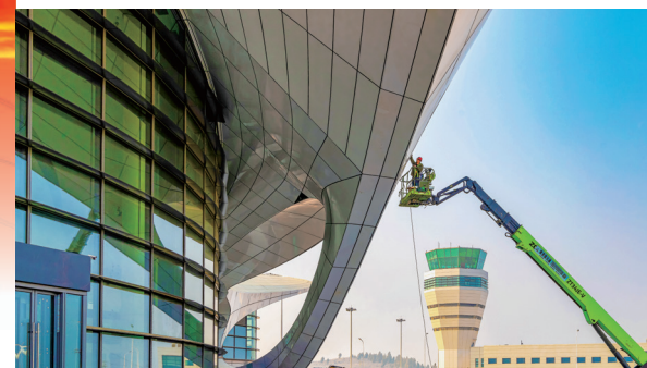
» 建设者高空作业，以匠心安装航站楼幕墙，为枣庄翼云机场的宏伟蓝图添砖加瓦。 《凌空匠心》李全明
